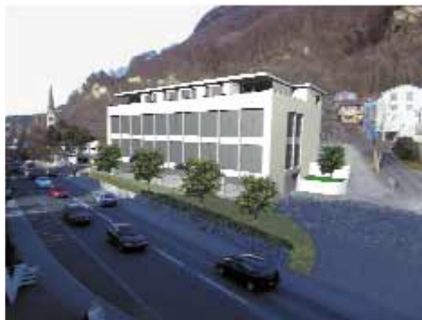
Maquette du bâtiment, en construction, qui abritera le futur Siège de VALORLIFE à Vaduz
