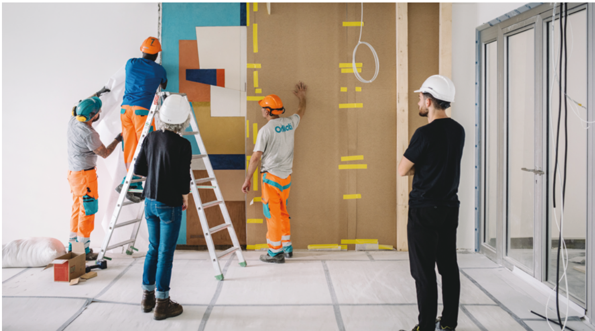
Sämtliche Kunstwerke in situ wurden restauriert. © Agence Muto
